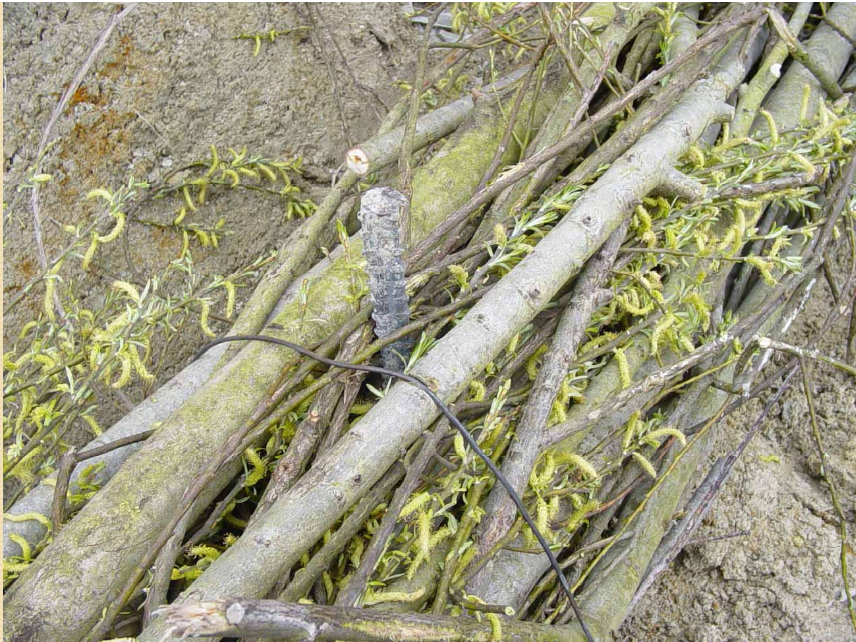
FASCINATA VIVA legata con filo di ferro cotto e fissata con picchetti di ferro ad aderenza migliorata
