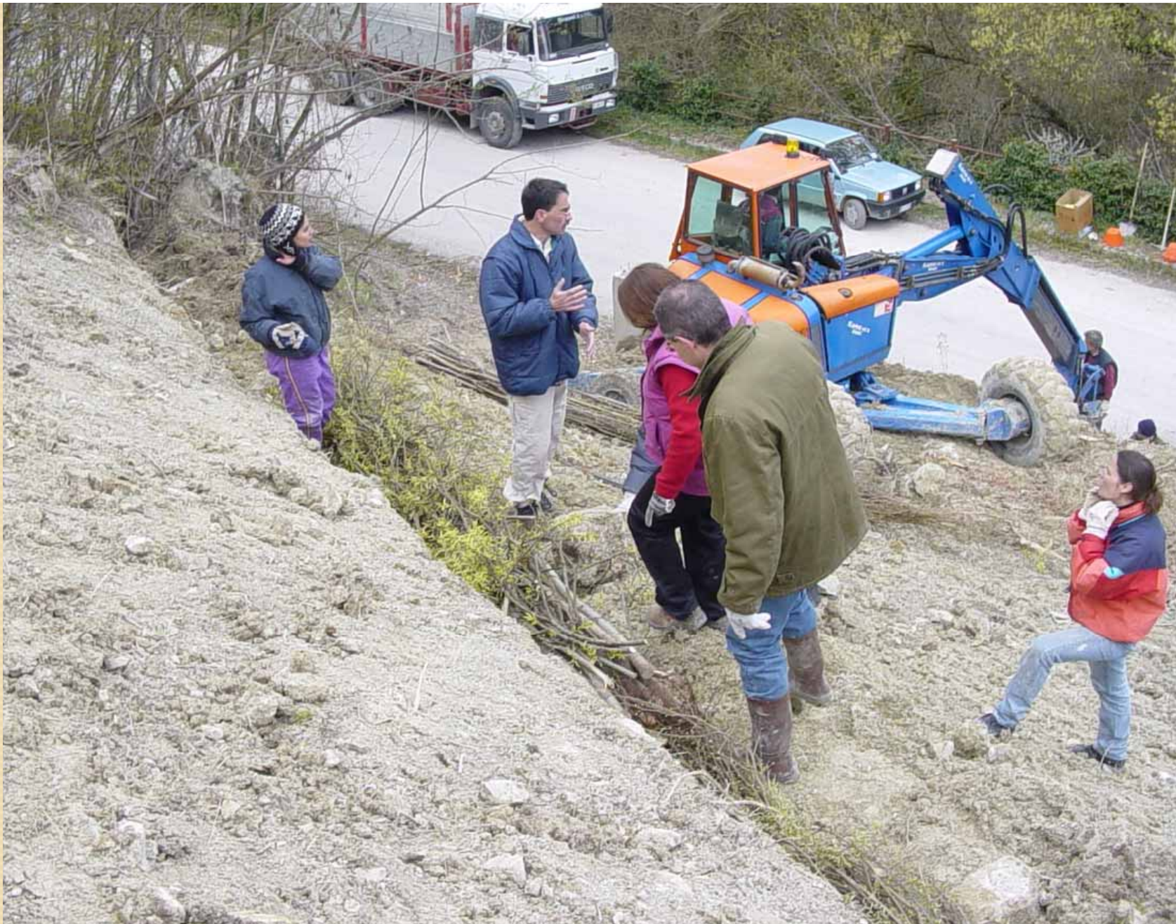
Scavo della trincea e posa in opera di FASCINATA VIVA
