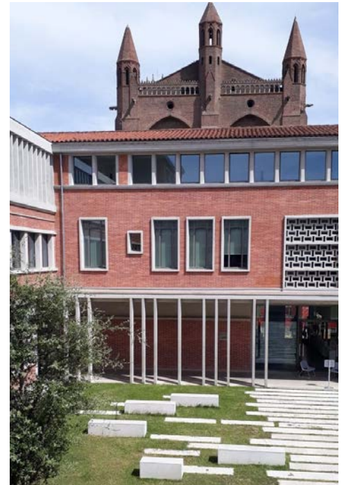
LYCEE FERMAT TOULOUSE (31) Éléments de façades en béton gris
