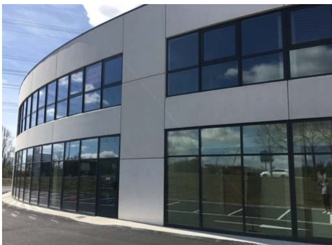
BUREAUX EUROCENTRE CASTELNAU D'ESTRETEFONDS (31)
