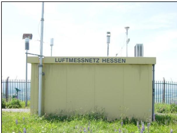
Abbildung 31: LUG-Station Wasserkuppe – Messcontainer.
