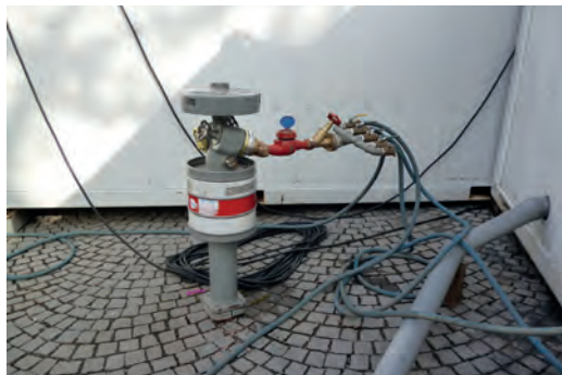
Abb. 42: Beispiel für eine Armaturo zur Wasserentnahme für Toiletten / Gastronomie, wobei der Hydrant für die Feuerwehr weiter nutzbar bleibt (freier Abgang und Druckentlastungsmöglichkeit)
