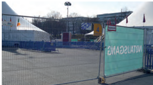
Abb. 7: Bauzaun mit Rollen als Flucht- und Rettungsweg inklusive Kennzeichnung (außerhalb des Betriebs).
