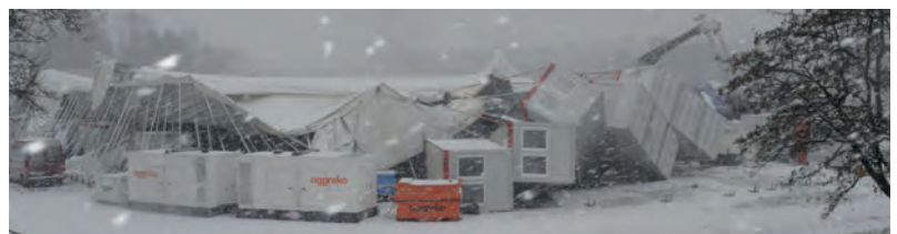
Abb. 47: Das Veranstaltungszelt am nächsten Tag. Trotz Maßnahmen der Feuerwehr in der Nacht, konnte ein Einsturz nicht verhindert werden. Die Kraft des Windes war so groß, dass sogar Baucontainer umgeworfen worden sind.
