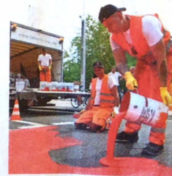
Roman Rein (großes Bild) bringt die rote Markierung aus Reibeplastik auf, sein Kollege Felix Proemmel (Bild unten, rechts) kippt die Flüssigkeit auf die Straße und Danny Bergmann (im Hintergrund) mischt die Farbe an. FOTOS: KATRIN KUTTER
