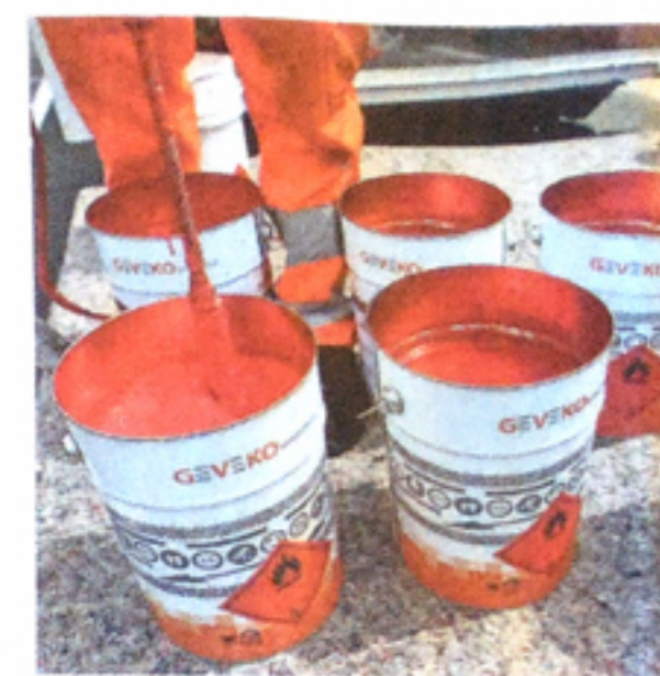
Roman Rein (großes Bild) bringt die rote Markierung aus Reibeplastik auf, sein Kollege Felix Proemmel (Bild unten, rechts) kippt die Flüssigkeit auf die Straße und Danny Bergmann (im Hintergrund) mischt die Farbe an. FOTOS: KATRIN KUTTER
