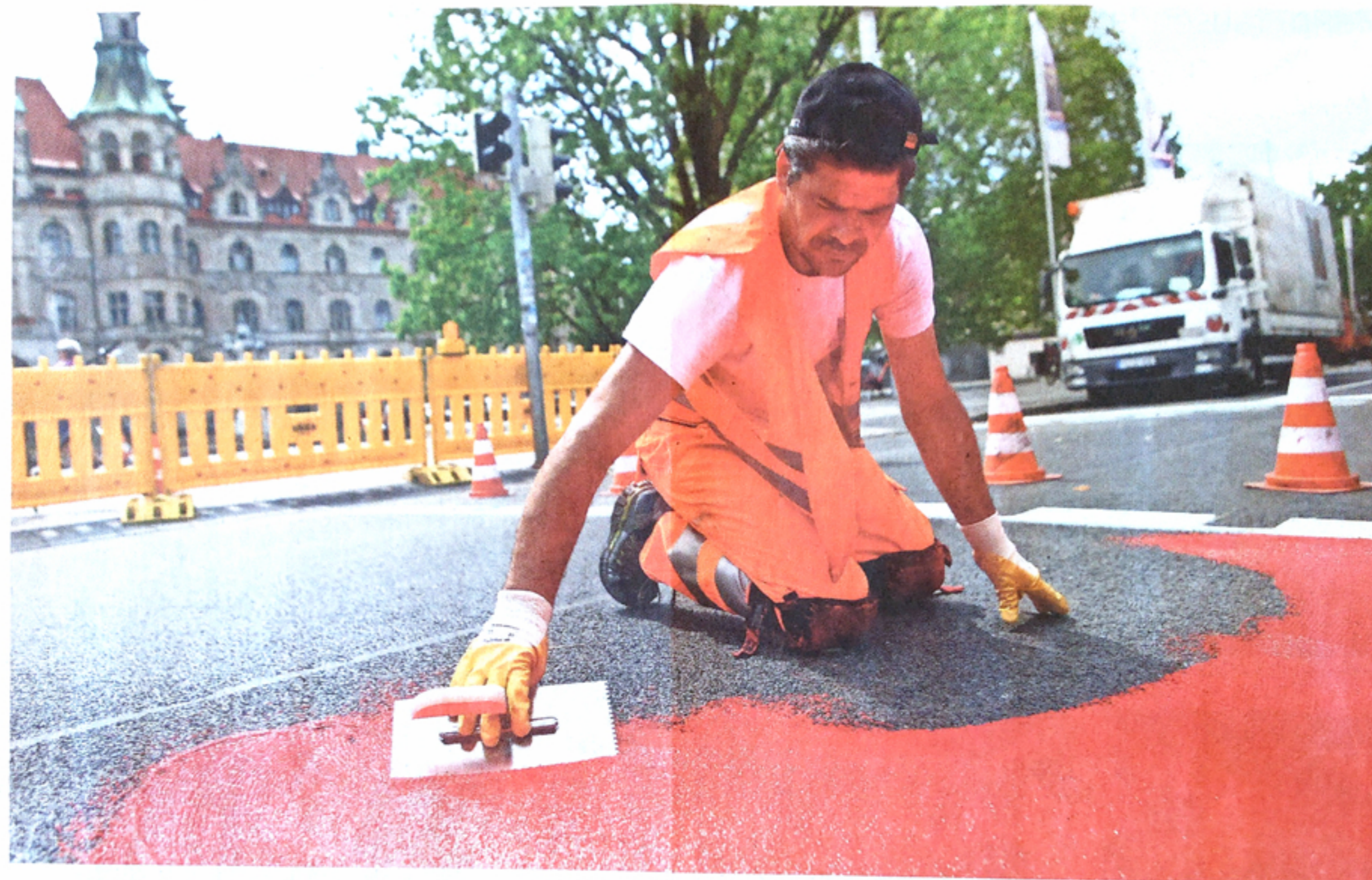
Roman Rein (großes Bild) bringt die rote Markierung aus Reibeplastik auf, sein Kollege Felix Proemmel (Bild unten, rechts) kippt die Flüssigkeit auf die Straße und Danny Bergmann (im Hintergrund) mischt die Farbe an. FOTOS: KATRIN KUTTER
