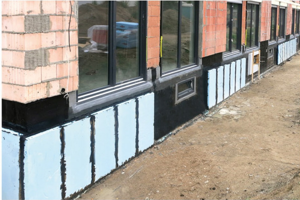
HELMA Wohnanlage, Hannover
