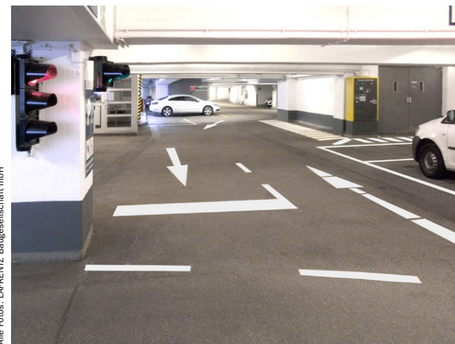
Projektbeispiele für Sanierung und Markierung von LAFRENTZ: Alsterhaus Hamburg, ungedämmtes Parkdeck in Gussasphaltbauweise ...
