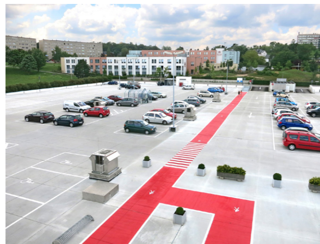
... und Einkaufszentrum Elster Park Plauen: Wärmegedämmtes Parkdeck als Warmdach mit PP-Faserbeton
