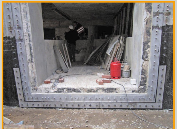
Nachrüstung U-Bahn Station Markthalle/Landtag Hannover
