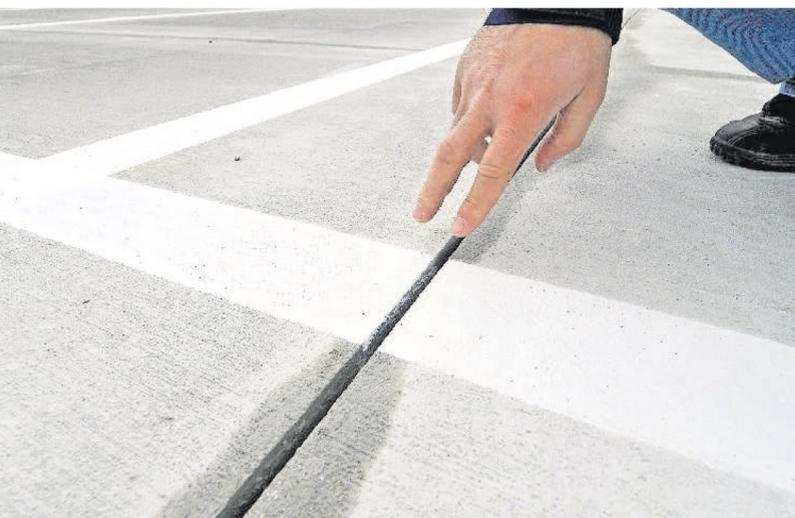
Die deutlich sichtbaren Schlitz in der neuen Betonfläche sind technologiebedingt und werden erst nach dem Winter verfüllt. Der Grund: Der Beton wird in den nächsten Wochen noch etwas schrumpfen. Auch die Randabdeckungen des Parkdecks bekommen deshalb erst im Frühjahr ihren Endzustand.
