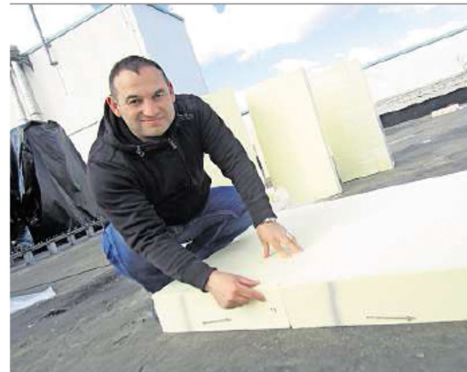
Bauleiter Mustafa Pekuzak zeigt die Beschriftung auf der Gefälledämmung aus Kunststoff. Die verschiedenen Höhen der Platten ergeben später das Gefälle des Parkdecks.
