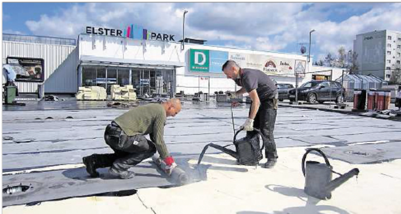
Zwei Mitarbeiter der Lafrentz-Baugesellschaft tragen flüssiges Bitumen auf die Dämmung auf. Bis Ende Mai soll das Parkdeck des Elster Parks fertig saniert sein. Für das gesamte Parkdeck werden insgesamt rund 1000 Kubikmeter Beton eingebaut.
