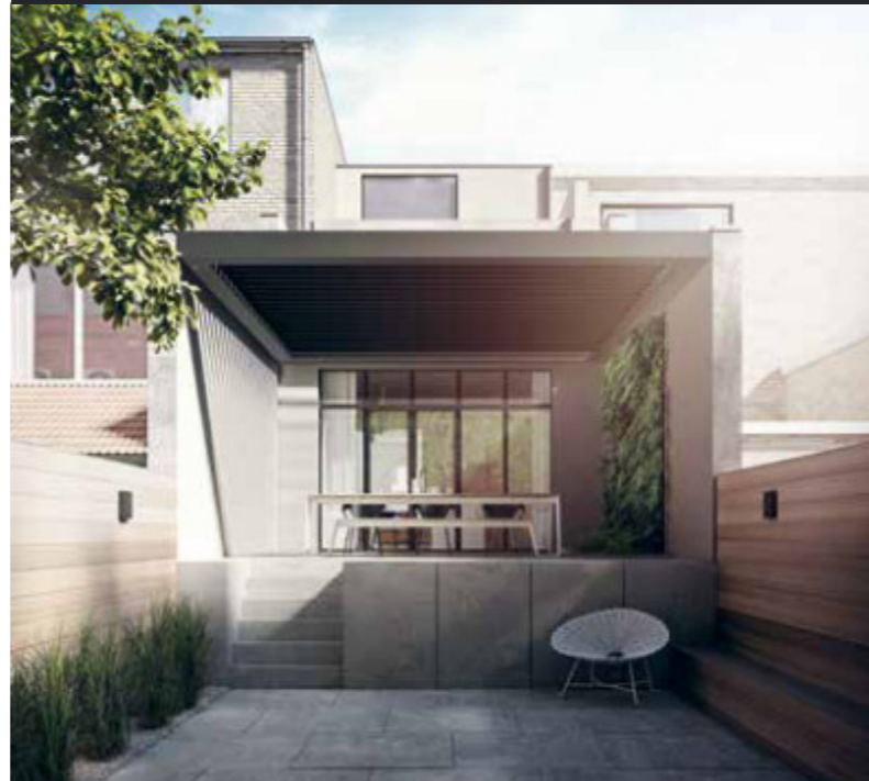
Eingebaute Pergola · ohne Pfosten (nur Dach)
