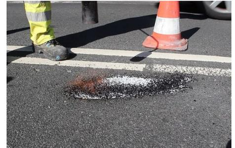
Die heiß eingebaute Thermoplastik ChipFill® für Schlaglochsaniegerung ist herkömmlichen, kalt applizierten Reparatursystemen hinsichtlich der Haftung zum Asphalt überlegen. Durch das Aufheizen auf ca. 220°C und mehr entsteht eine hervorragende Verbindung mit dem Bitumen im Asphalt.
