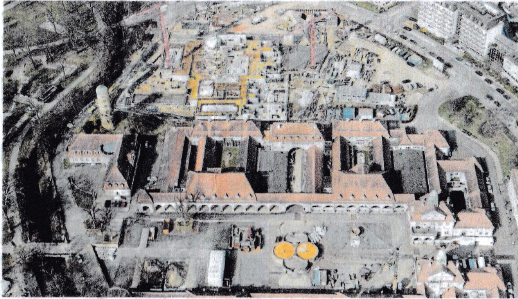
Blick auf die verriegelte Baustelle: Die BI »Rettet den Sprudelhof« fordert mehr Informationen über die Baufortschritte und hält nichts von einer Theaterspielstätte.
