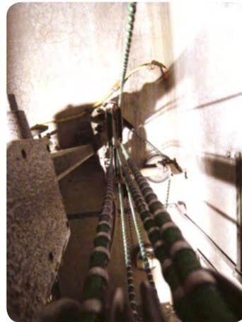
Hilos diamantados fabricados según los campos de aplicación y el tipo de material a cortar. Por favor, indique al momento de consultar o pedir, el tipo y fabricante de la máquina de trabajo.
