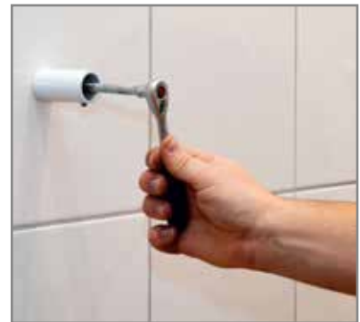
Zweites Anschlussstück montieren und ausrichten.
