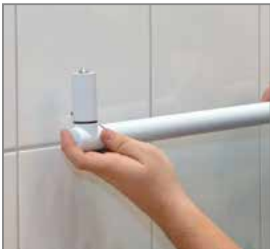
Der praktische Markierer (Dorn) hilft beim Anzeichnen.
