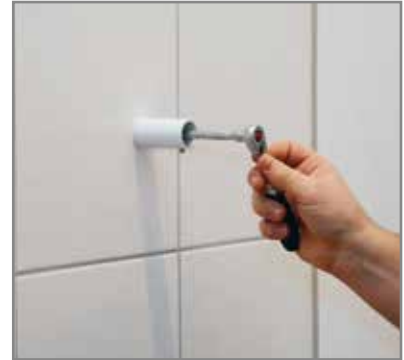
Anschlussstück an der Wand montieren.
