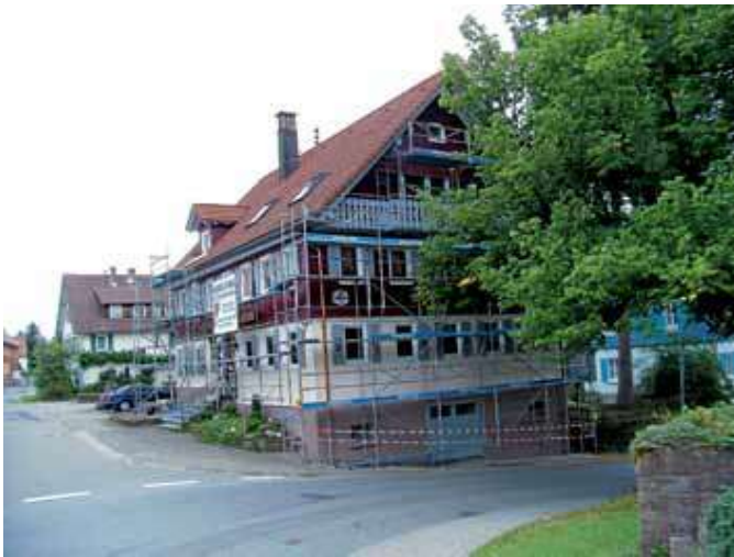
Ein Baugerüst hatte das Goldene Lamm 2012, wo es eine Außenrenovierung erfuhr.
