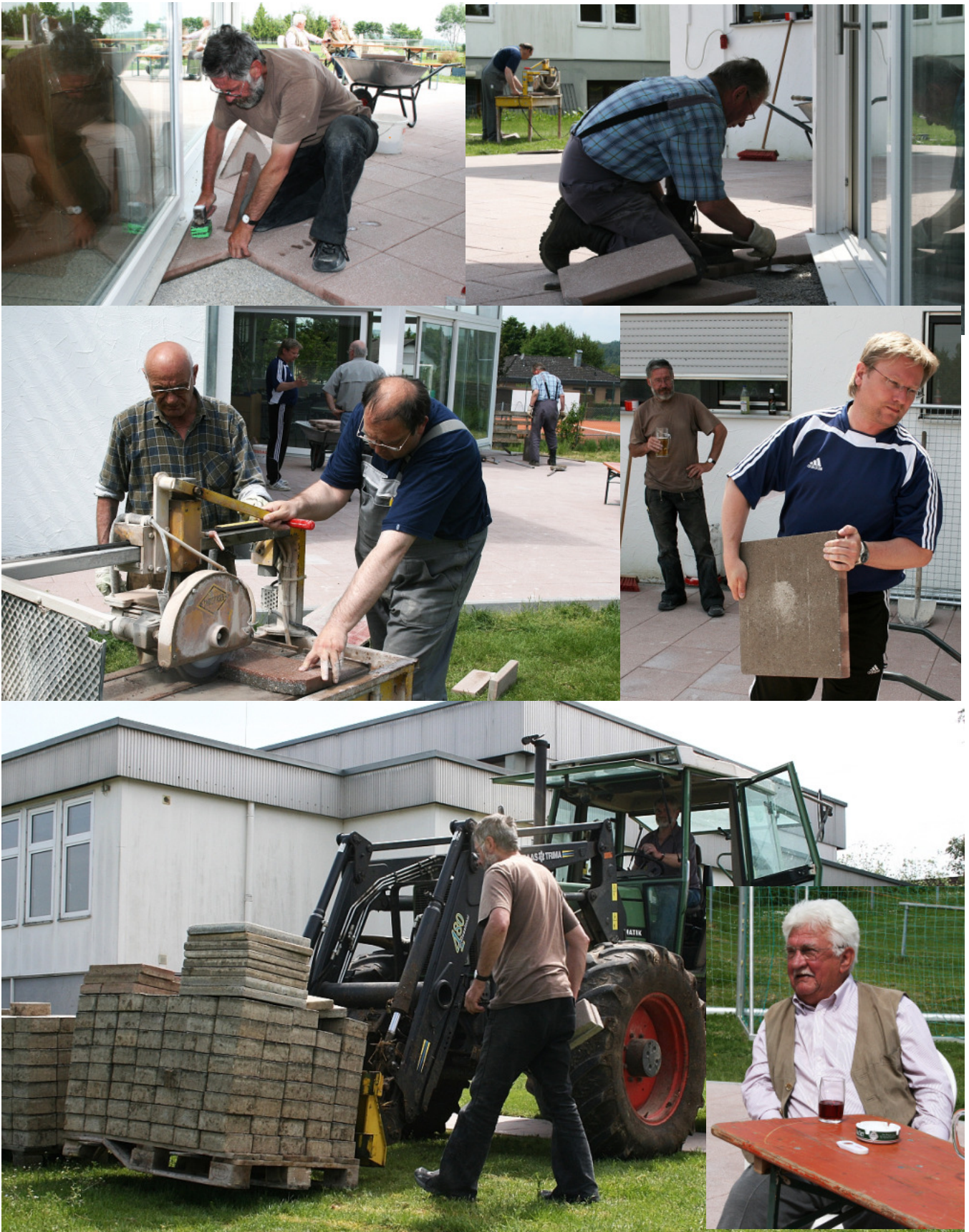
Unter dem freundlichen Zuspruch von Seppi Fuchs entstand in gut einer Woche eine ansehnliche neue Terrasse, die ab sofort den Gästen von Elke Piechotta zur Verfügung steht. Der ASV Bildechingen bedankt sich bei nachfolgend aufgeführtem "Bautrup" für deren unermüdlichen Einsatz: Gebhard "Gebe" Steimle, Erwin Rebmann, Bruno Gabriel, Julian Gabriel, Josip Colina, Jochen Steimle, Siggie Conradi, Alex Welzel, Olli Welzel, Klaus Piechotta, Werner Utek und Rolf Holderried.
