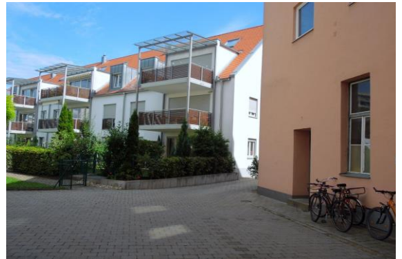
Der Innenhof der Wohnanlage
