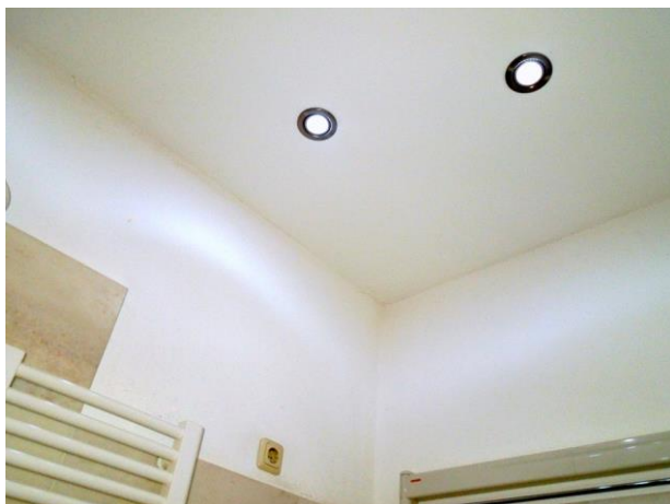
Versenkte Deckenspots :stilsicheres Design!
