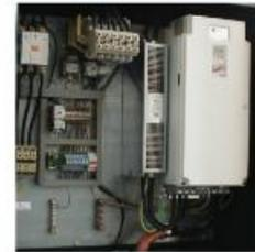
Los convertidores de frecuencia utilizados en los compresores EKO-VST están equipados con filtros y bobinas de entrada de alta frecuencia, que evitan armónicos de corriente y por lo tanto cumplen con las normativas de la CE.
