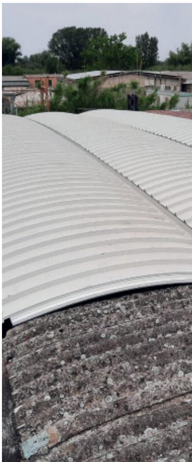
Bonifica, rimozione, trasporto e smaltimento della copertura in cemento amianto per un totale di mq 1.300 circa.
