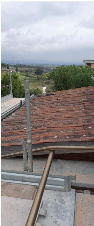
Bonifica, rimozione, trasporto e smaltimento di 160 mq circa di lastre in cemento amianto poste a copertura del fabbricato. Realizzazione nuova copertura mediante fornitura e posa in opera di pannello in fibrocemento ecologico.
