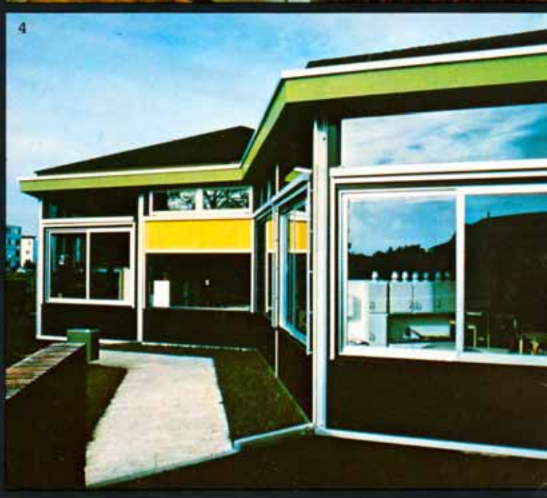
1 + 4 : Rambouillet : groupe scolaire. Arch. : AUFAURE (Paris). 2 : Nœud de liaison alu/bois lamellé collé. 3 : Bad Homburg : Centre de recherche. 5 : Hérouville-St-Clair : Centre d'informatique. Arch. : CLOT et DUPUIS (Caen).
