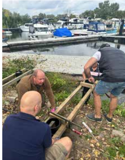
Perfekte Teamarbeit: Einmessen und Füllen der neuen Pfähle
