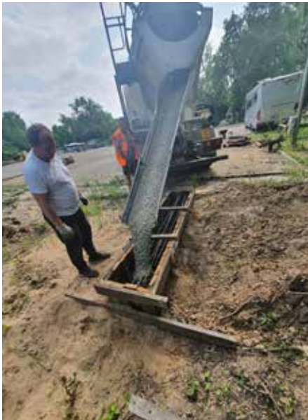
Ende Mai wurde das Fundament für den Container gesetzt.
