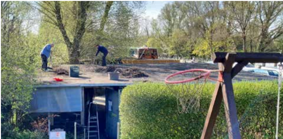
Hauptsache schwindelfrei: Ein Team kümmerte sich um die Reinigung und Abdichtung des Dachs vom Geräteschuppen.
