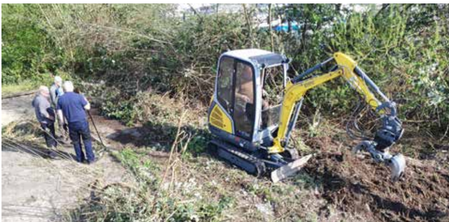
Entfernung von Wurzelwerk und Gestrüpp
