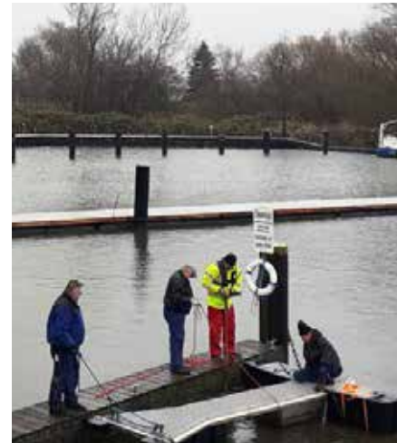
Montage der Ausleger auf den Schwimmelementen
