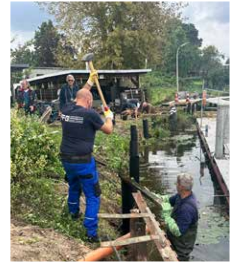
Einschlagen der neuen Pfähle
