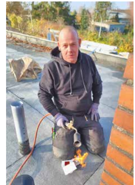
Dachdecker-Profi Marc Sierck repariert parallel zum Stegbau das Dach des Clubhauses
