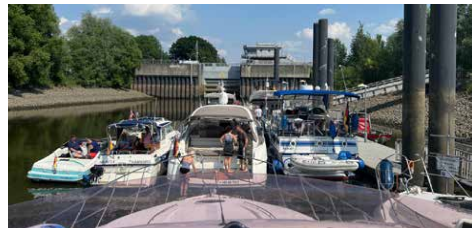
Stau an der Schleuse: Außer 2 x rotem Licht für „Außer Betrieb“ gab es keine Infos, was los war oder wie es weitergehen könne von der HPA.
