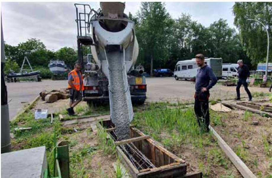
Ein großer Betonmischer wurde präzise zum Verfüllen der ausgehobenen Fundamentlöcher positioniert.
