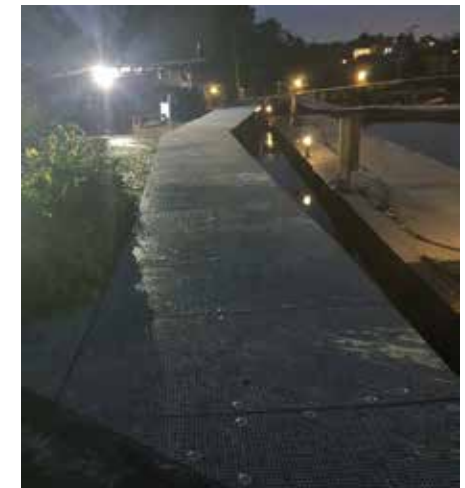
Geschafft! Am 7. Oktober abends war der neue Rundsteg fertig.
