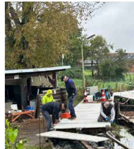
Platte für Platte wurde sorgfältig ausgerichtet und verlegt.
