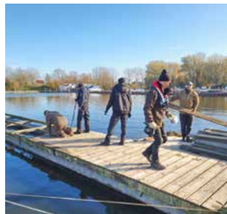
... und dann wird Brett für Brett abgebaut.
