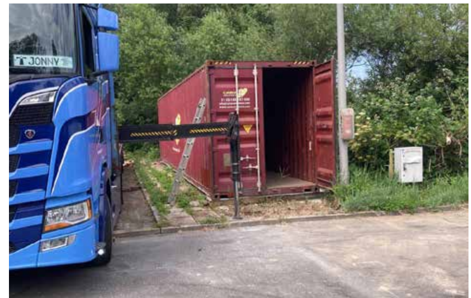
Nach dem Durchrocknen des Fundaments wurde der (fast) neue Container aufgestellt.
