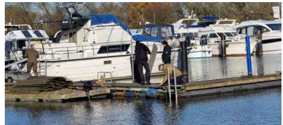
Die demontierten Bretter werden auf einem Schwimmponton zwischengelagert und an Land transportiert.
