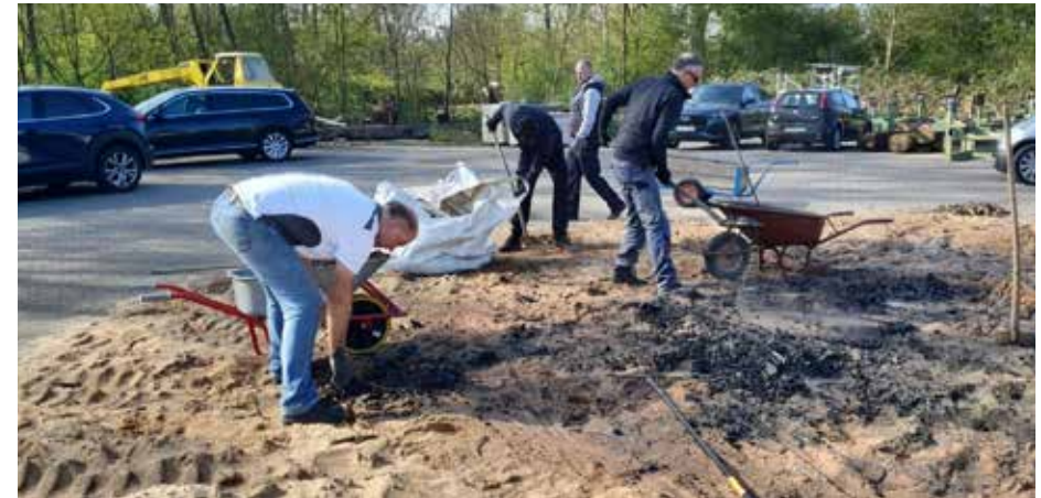
Sandarbeiten auf dem großen Parkplatz: Gute Muckis waren gefragt
