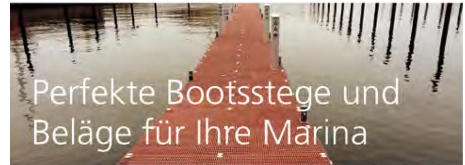
Unterkonstruktion, Gitterrost und Handlauf – Bootsstege lassen sich komplett aus GFK fertigen. Sie sind robust, langlebig, korrosions- und seewasserbeständig. Der Belag mit Micromesh Gitterrosten sorgt für Rutschsicherheit und lässt sich leicht mit dem Hochdruckreiniger säubern. Für das perfekte Bild im Hafen.
