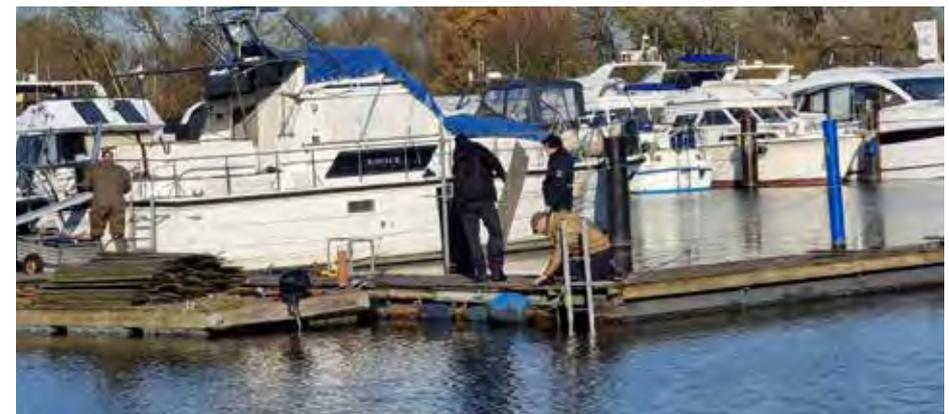
*Die demontierten Bretter werden auf einem Schwimmponton zwischengelagert. und an Land transportiert.*
