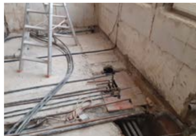
Der Gastraum des Clubrestaurants vor Verlegung des neuen Bodens
