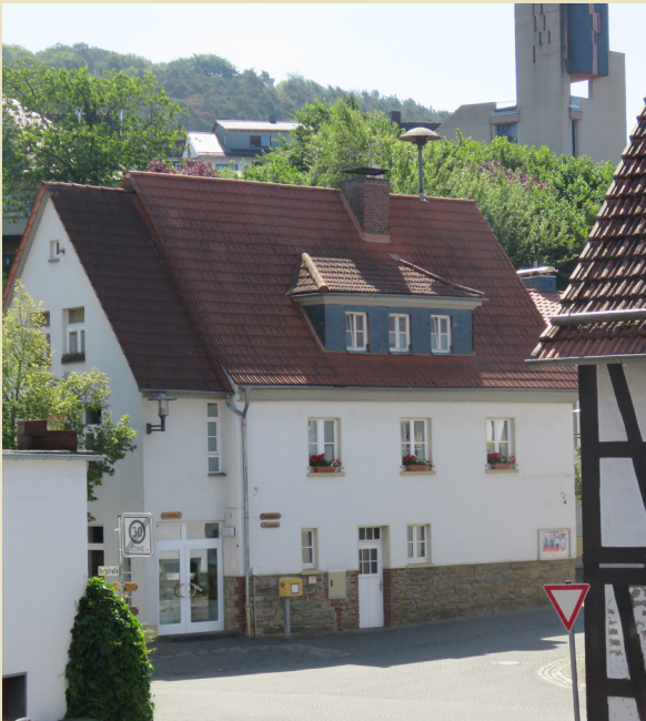
Das Gebäude des alten Rathauses beherbergt heute neben dem Backhaus die Heimatstube.
