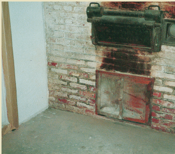
Der alte Backofen vor der Renovierung.
