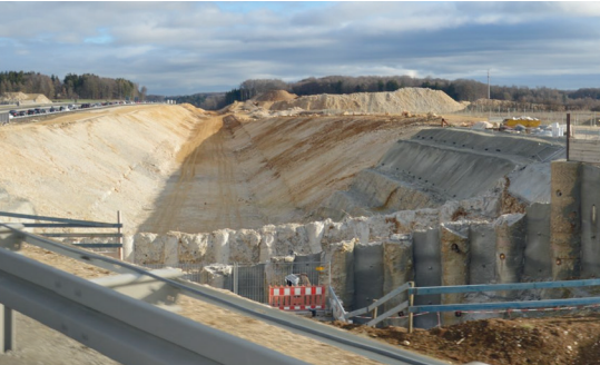
Bau einer zweigleisigen Bahntrasse am Ende eines Tunnels
