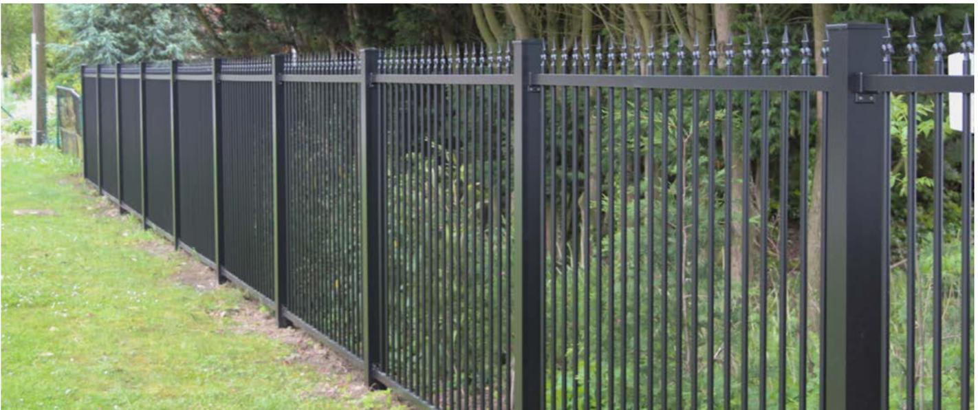
Obere und untere Querträger im Querschnitt 40 x 40 x 3,0 mm
