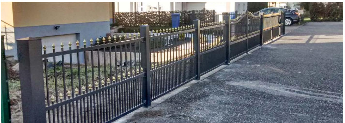
Umlaufender Rahmen aus Rohr 60 x 40 x 3,0 mm. Füllungsblech 2 mm. Beidseitig verbaut.
