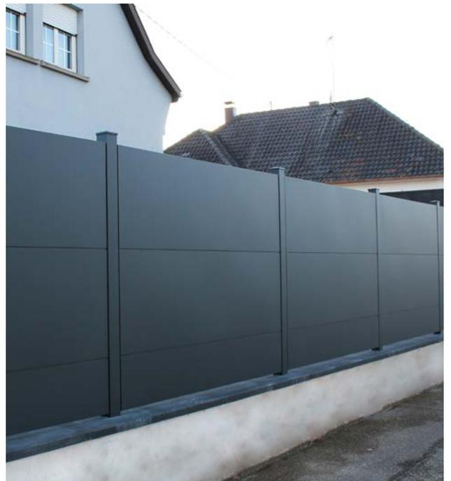
Umlaufender Rahmen aus Rohr 40 x 30 x 3,0 mm. Füllungsblech 2 mm. Beidseitig verbaut.
