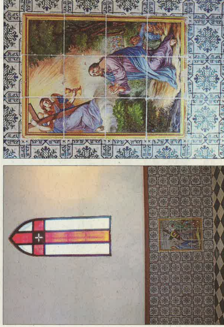
Paredes y azulejos restaurados y saneados de la capilla del Santísimo Cristo. AYO. DE EIVISSA
