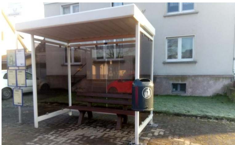
Neues Wartehäuschen an der Bushaltestelle Fürthen-Mitte (Quelle: https://www.fürthen-sieg.de/ )
