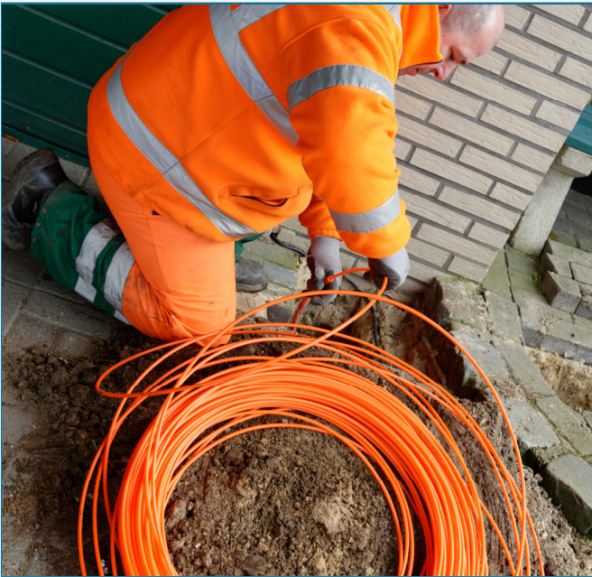
Aushub vor der Hauswand
