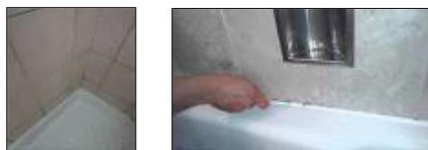
Fugen an Wannen und Duschtassen sind Wartungsfugen und sind entgegen landläufiger Meinung nicht dauerelastisch. Sie halten auf Dauer nicht dicht und verhindern so auch nicht unbemerkt herunterlaufendes Wasser in darunterliegende Wohnungen. Es droht Versicherungsverlust.
