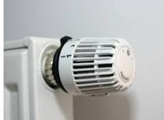
Beim Wechsel zu kalten Temperaturen wird der Heizkörper oft nicht ausreichend warm obwohl das Thermostat hochgestellt ist.
