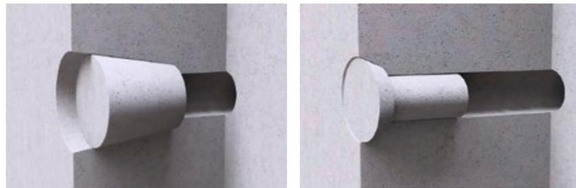
Detaillierte Spannstellen sind Akzente in der massiven, homogenen Betonfläche. Art und Verschluss der Spannstelle entscheiden auch über die Wirkung der Spannung der Betonoberfläche. Die Tiefe des Verschlusses bestimmt die Sichtbarkeit der Spannstelle und deren Einfluss. Bündig verschlossene Spannstellen erweitern die Flächenwirkung.
