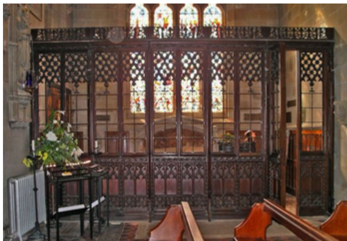
Una pantalla parclose en una capilla de la capilla, que permite la visibilidad
