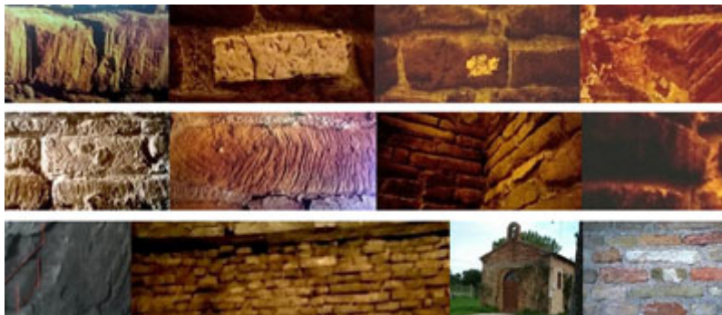
Piedras y ladrillos de la Santa Casa, de tiempos de Cristo cuidadosamente examinados en la investigación de 1965
