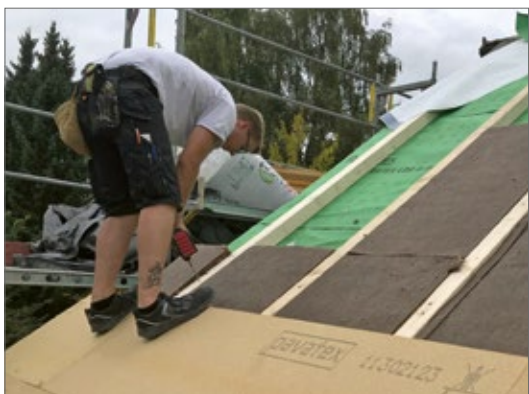
Dachsanierung einer Doppelhaushälfte mit Zwischensparrendämmung und Holzfasерplatten
