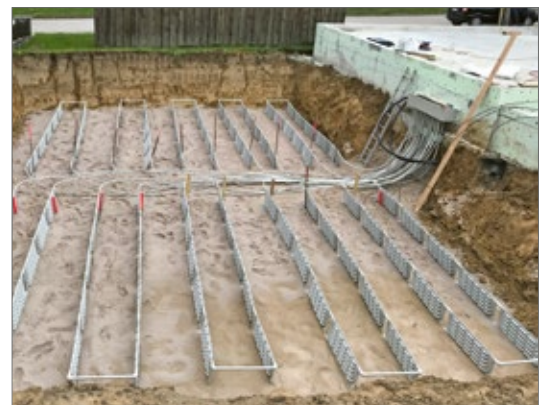
Erdkollektoren für eine Wärmepumpe: Nach nur zwei Tagen war die Baugrube wieder verfüllt.
