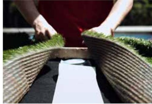
Klappen Sie ihn wieder auf und legen Sie mittig unter der Nahtstelle das Kunstrasen Tape, mit der Schutzfolie nach oben, auf. Ziehen Sie die Folie ab und drücken Sie den Rasen auf das Tape. Richten Sie die Halme an der Naht nach.
