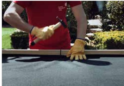
Klappen Sie den Überstand des Vlieses nach oben und legen Sie erneut überlappend eine Schicht Geovlies aus. Optional: Zusätzliche Fixierung des Vlieses mit Ankern.
