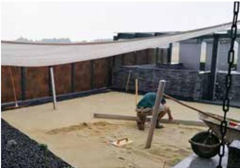
Verteilen Sie den Sand gleichmäßig und stellen Sie ein Planum her. Verdichten Sie den Boden und korrigieren Sie etwaige Unebenheiten.
