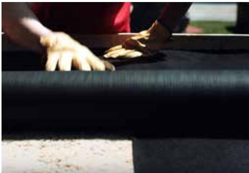
Klappen Sie den unteren Überstand des Vlieses hoch. Damit die Kiesschicht allseitig ummantelt wird, legen Sie darauf eine weitere Schicht Geovlies aus.
