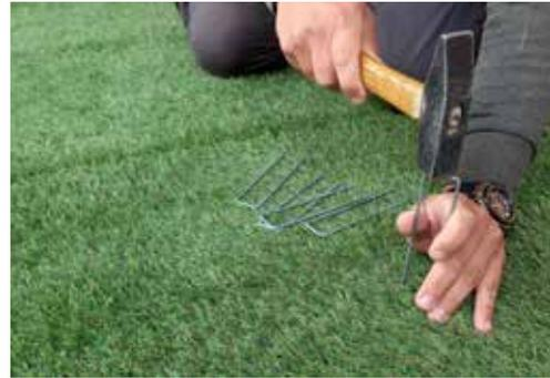
Befestigen Sie die äußeren Kanten mittels Rasenankern mit ca. 1 m Abstand. Bei höherer Nutzung des Rasens sind zusätzliche Anker in der Fläche von Vorteil.
