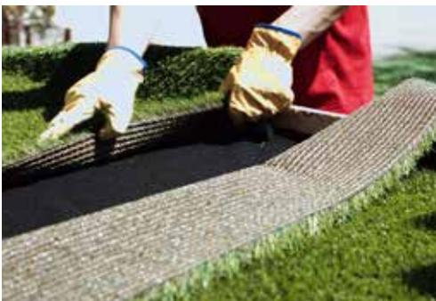
Falls Sie mehrere Bahnen verlegen bereiten Sie nun die Nahtverbindung vor. Dazu klappen Sie den Kunstrasen zurück.
