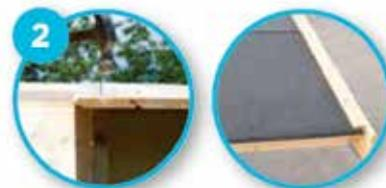
La plupart des abris repris dans ce catalogue sont fournis d'une toiture en planchettes de 16 mm et un feutre bitumeux noir.
