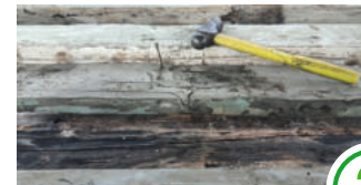
Entfernen von Nägeln, Schrauben und anderen Verbindungselementen
