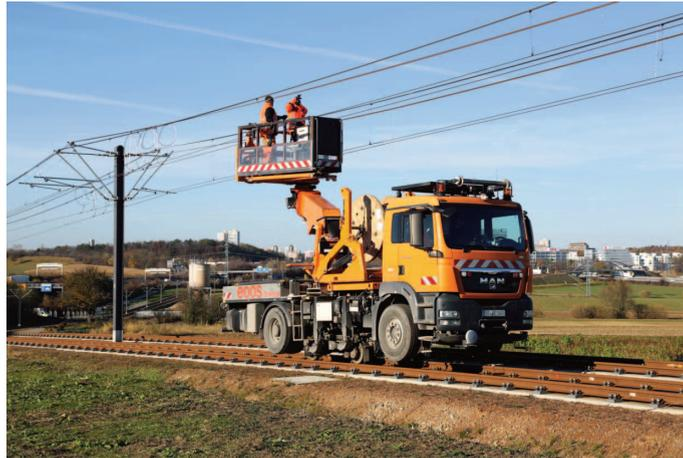
Kurz vor Erreichen der höchsten Stelle der Neubaustrecke werden noch letzte Arbeiten an der Fahrleitung vorgenommen. Die feste Fahrbahn ist mit einem speziellen Granulat bedeckt, in dem später Gras wachsen wird. Ganz rechts am Bildrand ist die Netzwerk-Bogenbrücke zu erkennen. Aufnahme: Rainer Vogler, 09.11.2021
