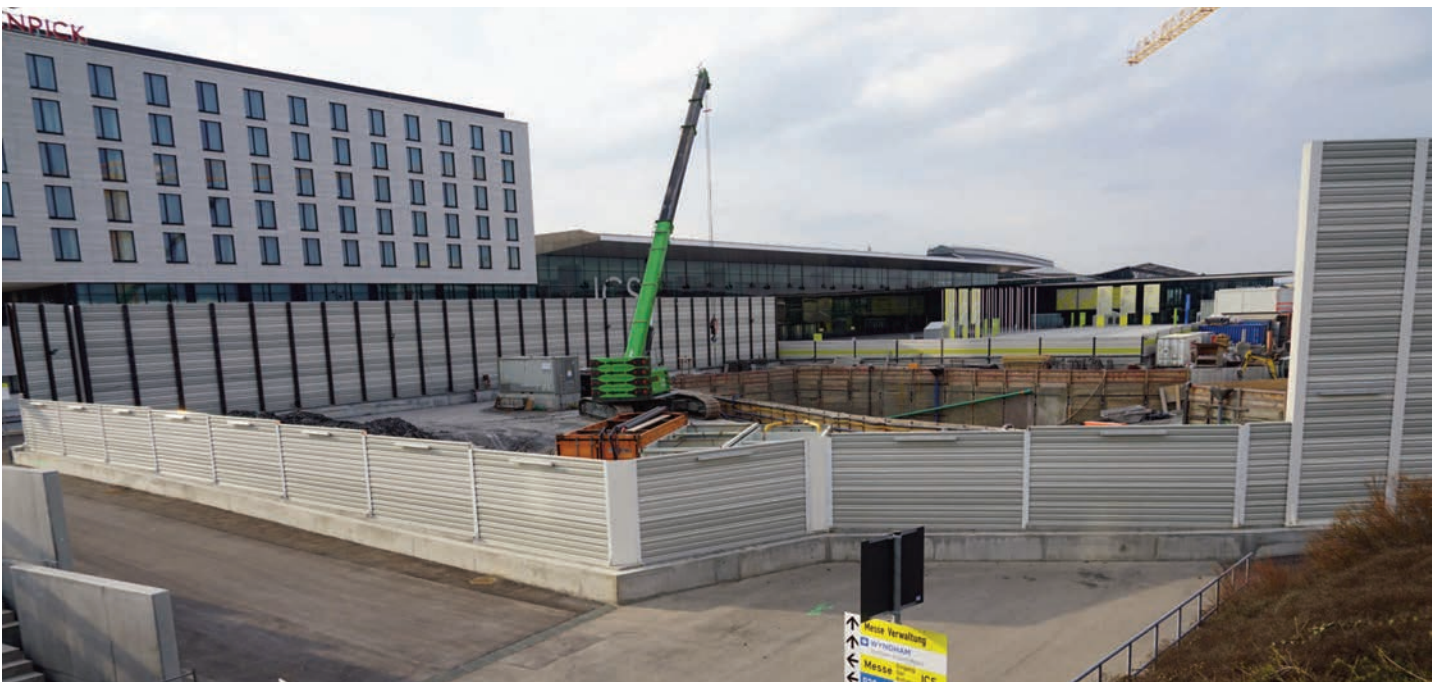
Die schwarzen Glashalle ist der Messe-Haupteingang. Große Teile der vorgelagerten „Messepiazza“ sind derzeit Baugrube für den S21-Filderbahnhof; später entsteht am rechten Rand der Grube der Bahnsteigzugang. Über den hellen Weg im Vordergrund geht es nach links über den Messeboulevard zum Airport bzw. zur S-Bahn. Über die dunkelgraue Fläche gelangt man zum Stadtbahn-Bahnsteig, unmittelbar vor dem Hotelbau gelegen.
