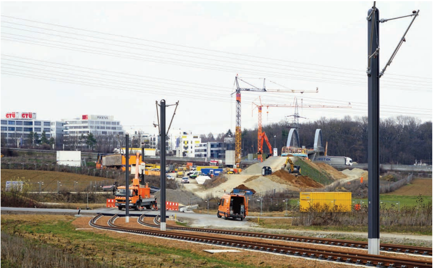
Bei SSB-km 3,900: Blick nach Norden auf die im März noch gleisfreie Südrampe zur Brücke über die BAB 8.
