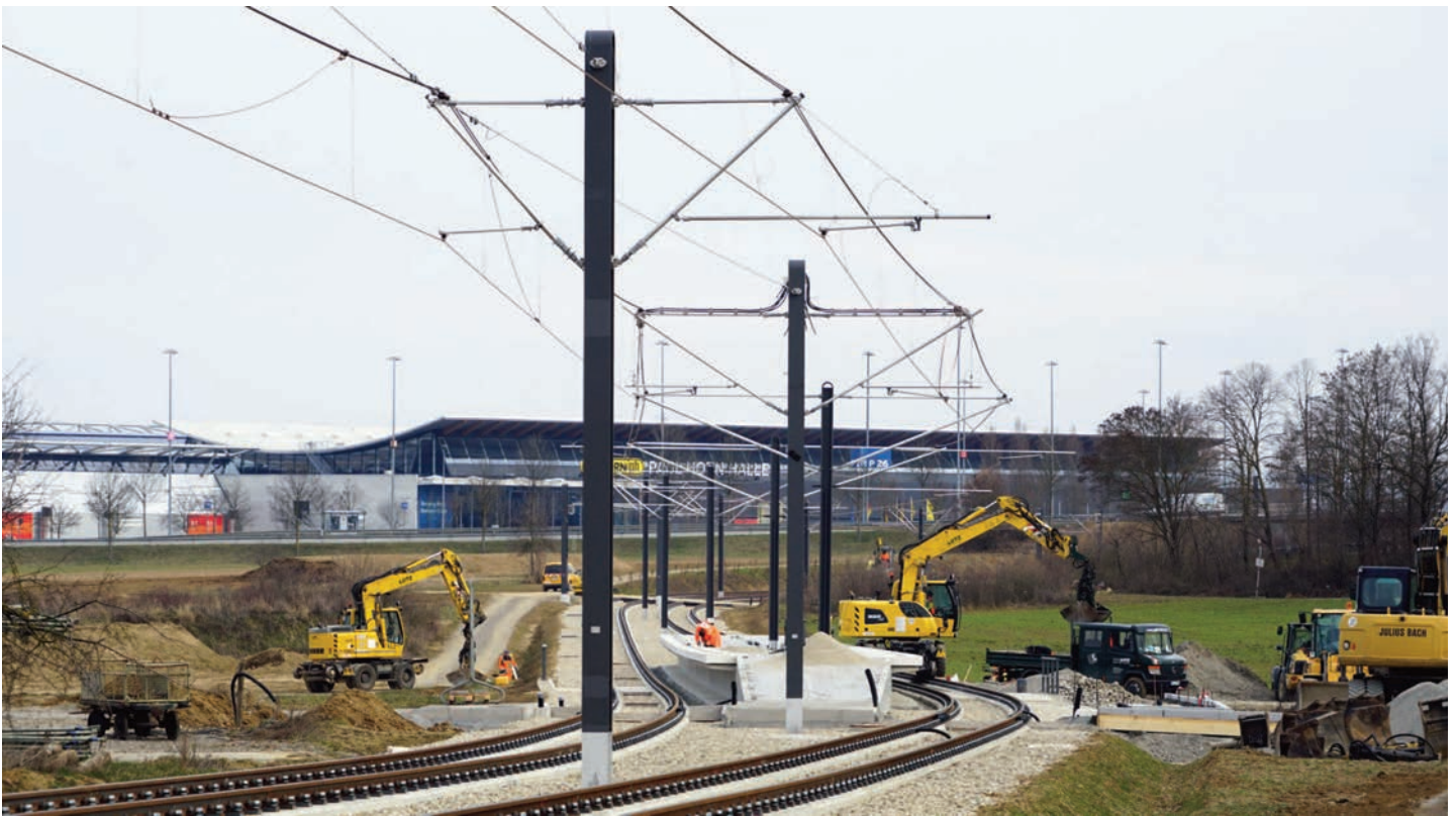
Bei SSB-km 4,400 Südostblick auf die zukünftige Haltestelle „Stadionstraße“ (Echterdingen); im Hintergrund ist die Messehalle 10 zu erkennen.
