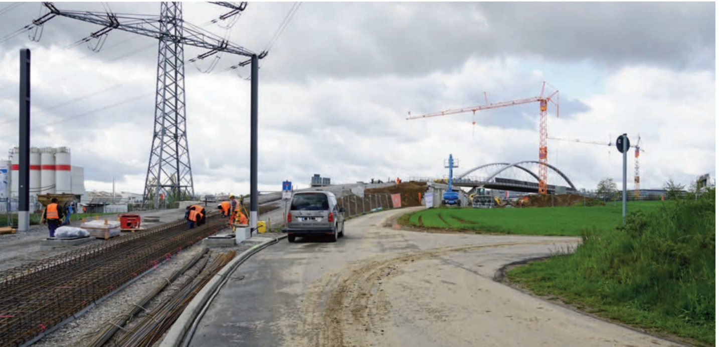
SSB-km 2,820: Blick von der U6-Endhaltestelle Fasanenhof Schelmenwasen nach Süden, die 8,5 %-Rampe hinauf zur Brücke über die BAB 8. Gerade sind die Arbeiter dabei, das Armierungseisen für die Beton-Streifenfundamente für das Richtungsgleis zur Messe zu verlegen.
