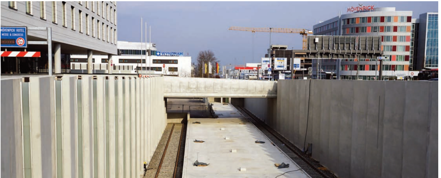
Bei SSB-km 5,857 Blick vom westlichen Treppenzugang in den im Rohbau fertigen Endbahnhof „Flughafen Messe“, links ist das kürzere Nordgleis mit dem Gleisende unter der Hotelzufahrt zu erkennen. Dahinter beginnt nach links die „Messepiazza“. Das rechte Gleis endet vor der schwarzen Wand im Hintergrund, dahinter liegt der „Messeboulevard“ zu den Airport-Terminals. Links oben steht der erwähnte Kongresshotel-Neubau.
