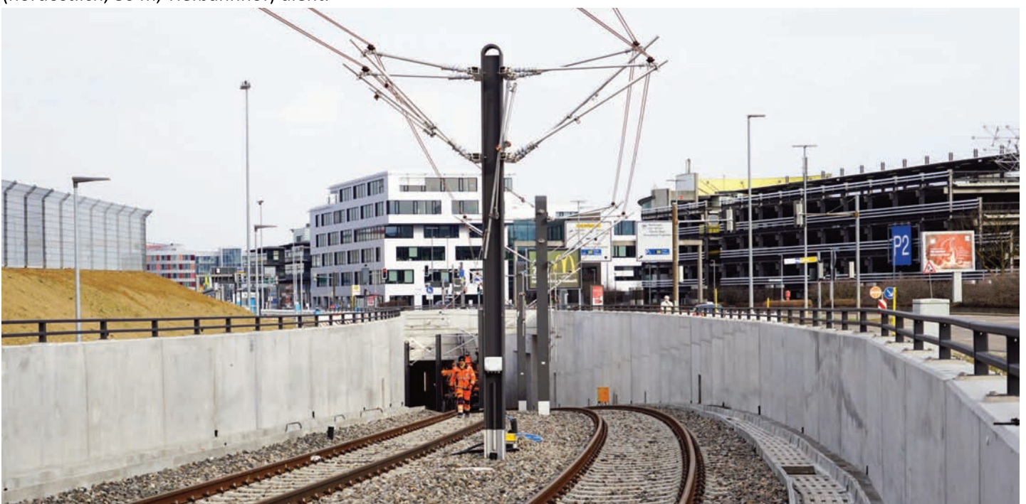
Bei SSB-km 5,270 am östlichen Ende der Haltestelle „Messe West“ beginnt die etwa 150 m lange Rampe in den zum Teil überdeckelten Trog zur Endhaltestelle.
