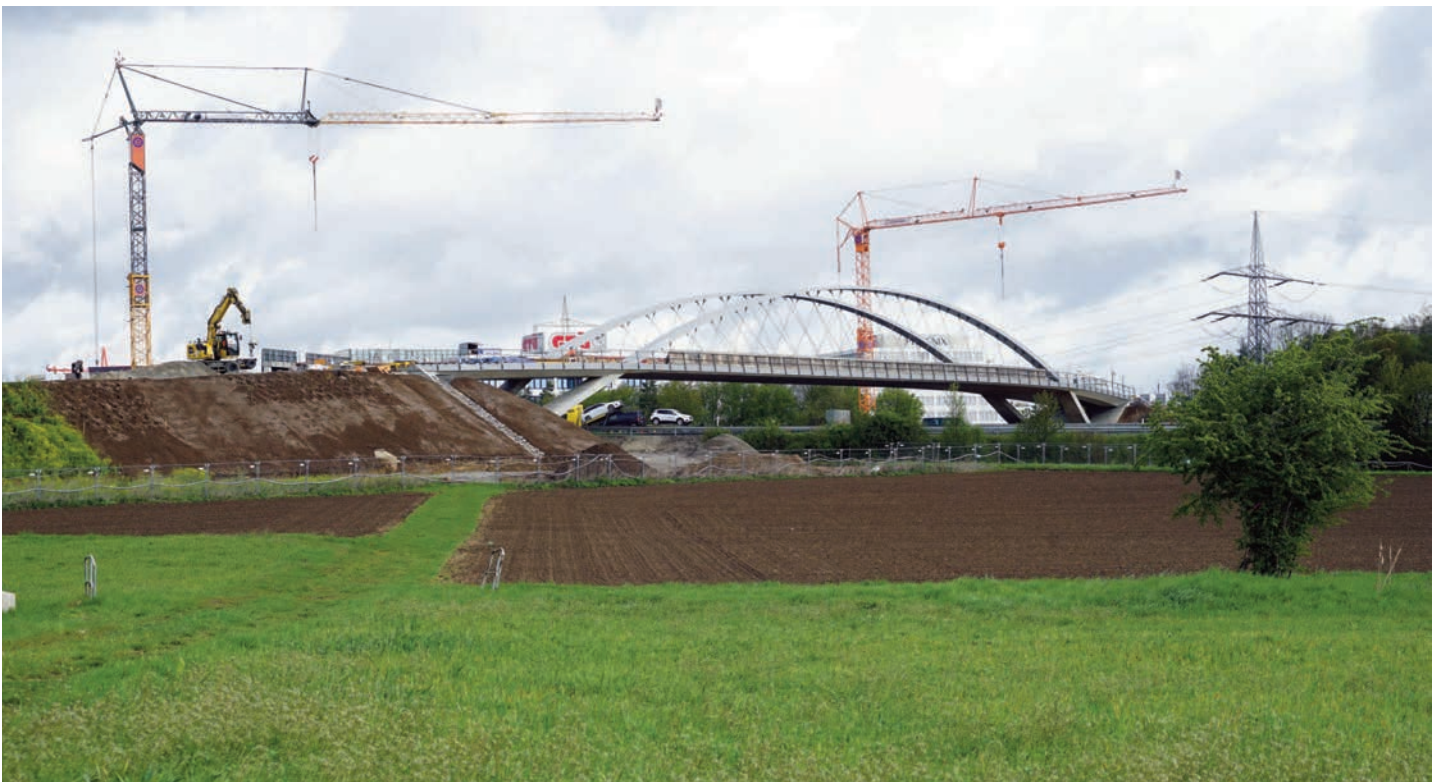
SSB-km 3,150: Blick von Südosten Richtung Fasanenhof Schelmenwasen auf die rund 130 m lange stützenlose Netzwerk-Bogenbrücke. Das rund 80 m lange Mittelteil wurde am 03.05.2020 in drei Stunden über die Autobahn geschoben und auf die V-Stiele aufgesetzt. Die seitlichen Holzbretter auf der Fahrbahnhöhe werden noch abgebaut. Sie dienen derzeit dem Schutz der Autobahn.
