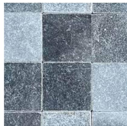
Pavage perméable en pavés drainant réalisés en coquilles d'huitre et coquilles saint-jacques recyclées associé au granit bleu normand et du massif armoricain.
