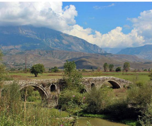
die alte Brücke über den Drinos
