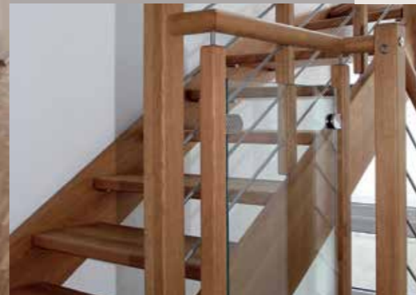
Wandwange Wangenbolzenlagerung
